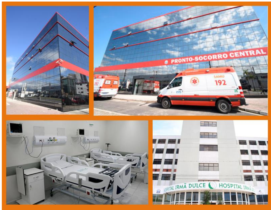
Ampliação da Estrutura do Complexo Hospitalar Irmã Dulce – novembro/2022. Fonte: Plano Municipal de Saúde 2022/2025.
